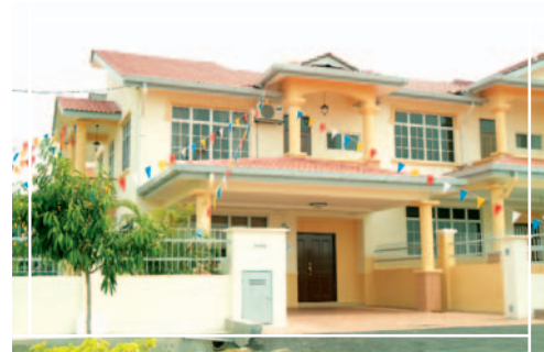
Desa Kolej - Showhouse
